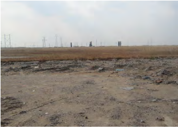
井场临时占地恢复情况
